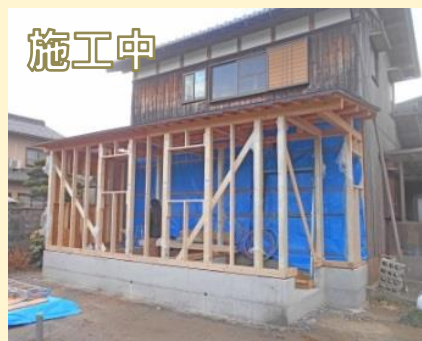
・ 棟上げ工事
