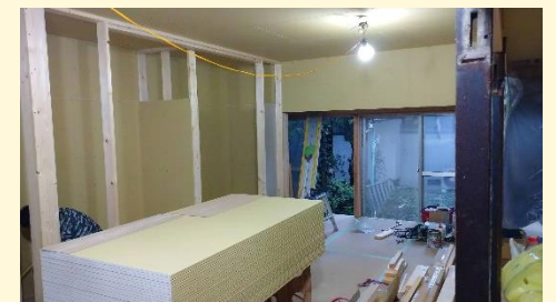
各下地にフローリングや石膏ボードを貼っていきます。
