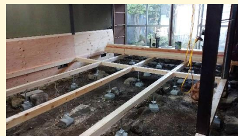
床下の土壌と既存部分に防蟻処理をし、床が水平になる様に大引材を設置しています。
