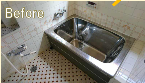
天井と壁がタイルで冬に寒い思いをされ、入口の段差も最近気になり出されていました。
