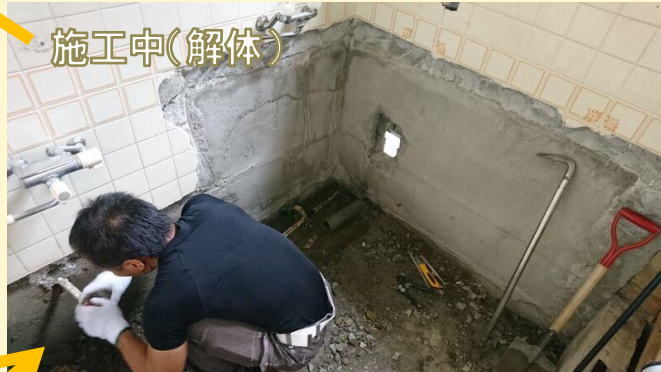
既存の浴室を解体し、新しいシステムバスに合わせて配管を仕込んでもらっています。
