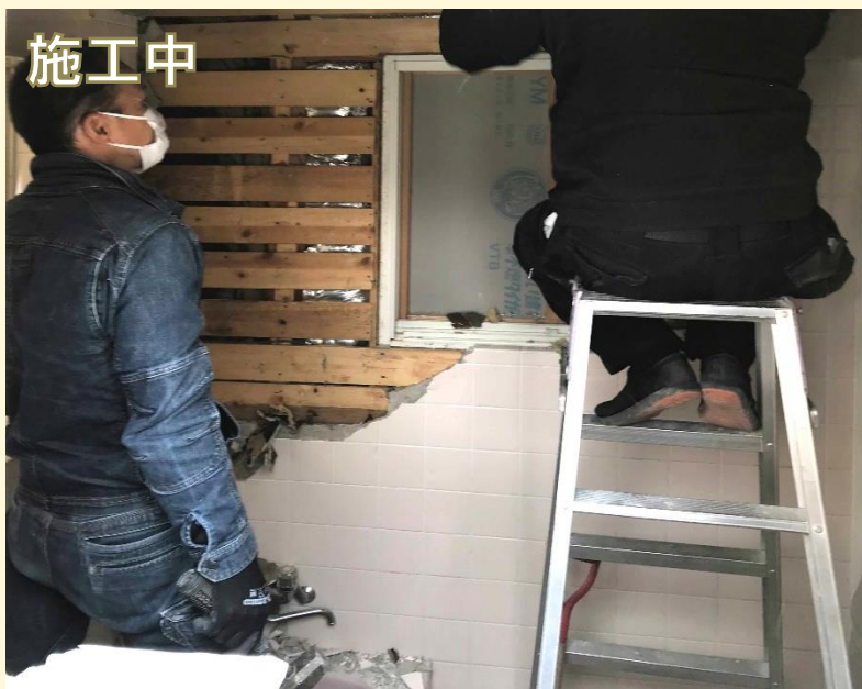
壁も天井も解体していきます。
