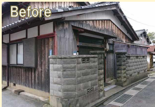
昔、厚めの焼き板を貼られ、長い間お住まいを守ってくれていましたが、経年劣化により色が落ちていました。
