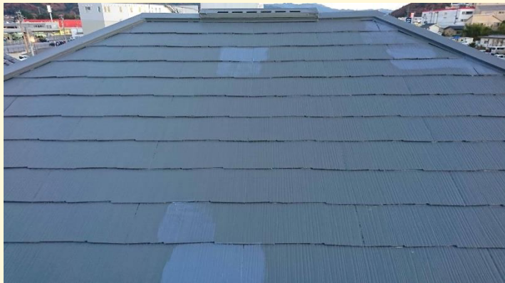
屋根の汚れもなくなり、とてもきれいになりました！
