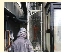
まず最初に建物全体の汚れを高圧洗浄機にて洗い落とします。
