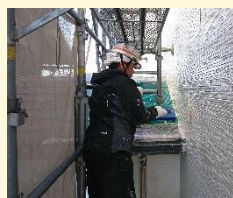
外壁に基準量の塗料を丁寧に塗装しています。
