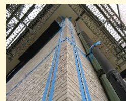
劣化したシーリング材を除去し、新しく打ち直します。
