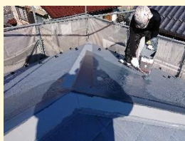
屋根は十分気を付けて塗装しています。
