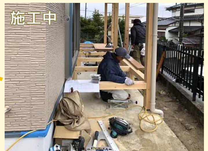
しっかりとした土台を組んでいます。
