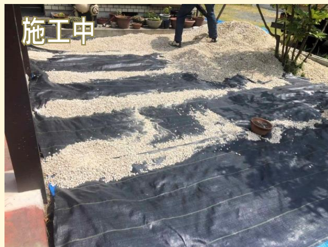
防草シートを敷いてその上に砂利を撒いています。
