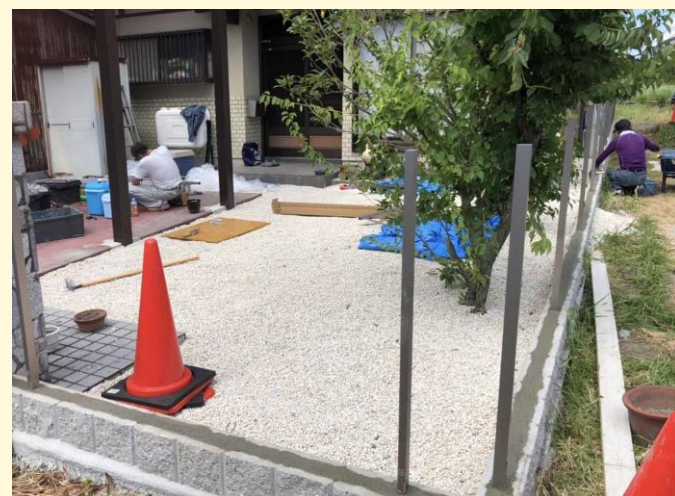
ブロックを並べてアルミのフェンスを組立ってます。
