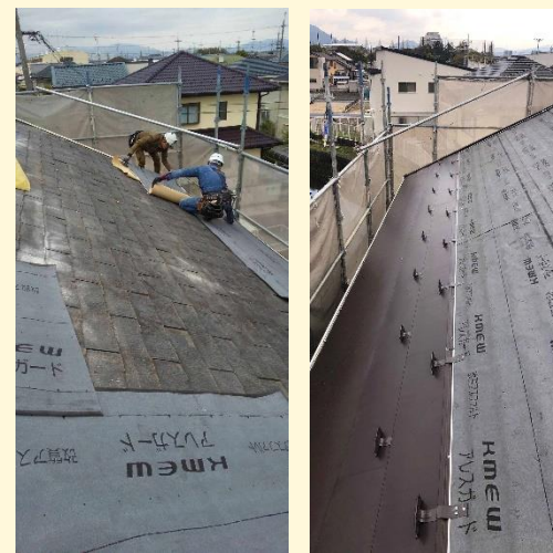
屋根下地防水シート施工。
