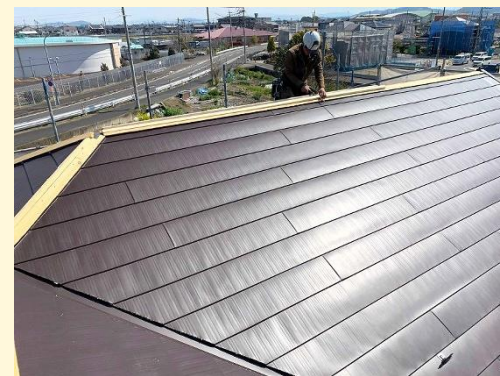
屋根カバー工法。
