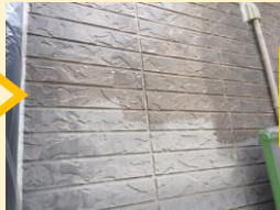
高圧洗浄後 下塗り施工
