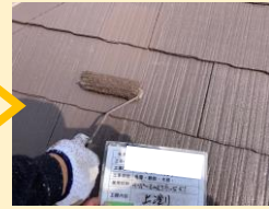
中塗り後 上塗り施工
