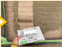
下塗り後 中塗り施工
