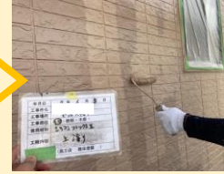
中塗り後 上塗り施工
