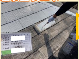
高圧洗浄後 下塗り施工
