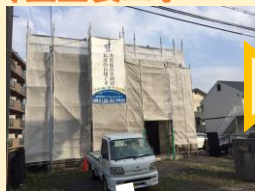
足場搬入 組み立て施工
