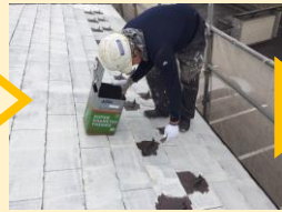
下塗り後 中塗り施工
