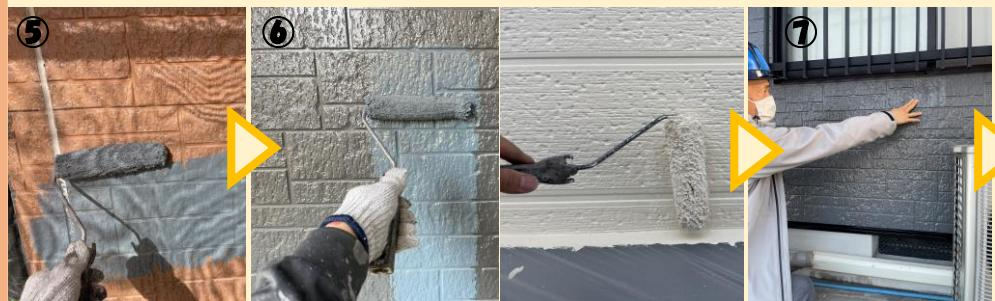
⑤ 外壁中塗り    ⑥ 1F・2F上塗り    ⑦ 自社による完了検査
