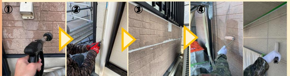
① 高圧洗浄施工    ② シーリング撤去    ③ シーリング打ち替え    ④ 外壁1F・2F下塗り
