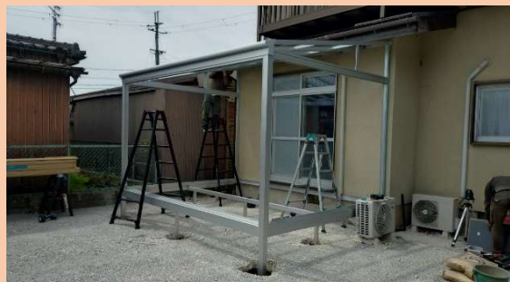
サンルームを役割分担で手際よく組み立てていきます。
