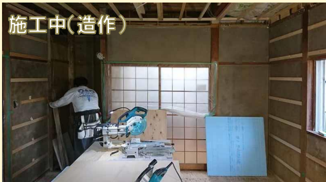
新しい床、壁、天井を貼るための下地を作っているところです。
