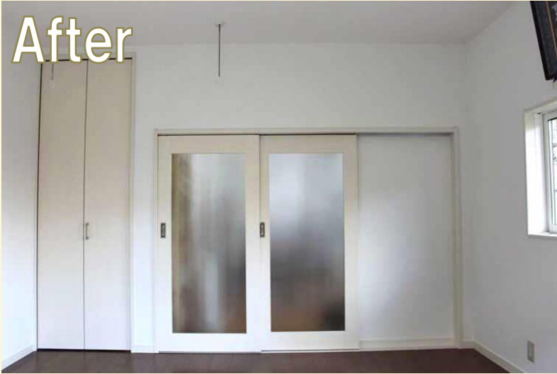
After ガラス障子の引違戸から、引込戸に変更しましたので、全開するとLDKが一体になります！
