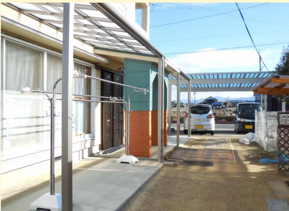
フラットのカーポートです。風の抵抗も少なくなります
