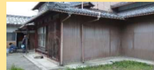
外部に水廻りの窓が並ぶ予定です。
