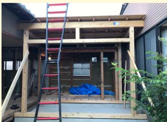
一度解体し、廊下を広くしました
