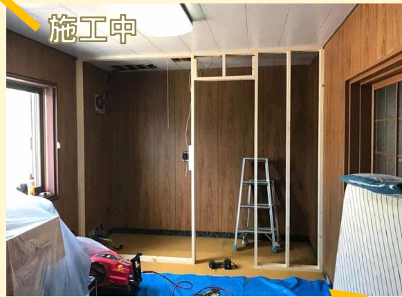
間仕切り壁を造作中です。
