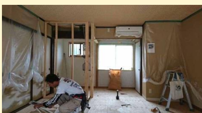
床にフローリングの下地合板を貼り、広くなる おトイレとの間仕切り壁の骨組みを組んで います。
