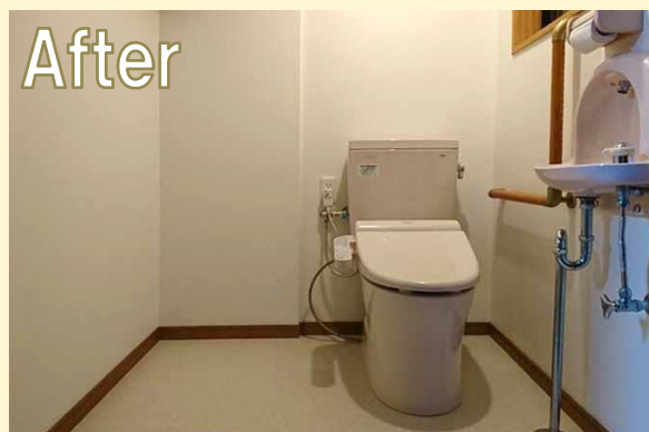
おトイレの中もかなり広くなりました。 車椅子でも十分中まで入れますし、 介助の方も一緒にいただけます！ (最低50cm以上のスペースが必要です。)
