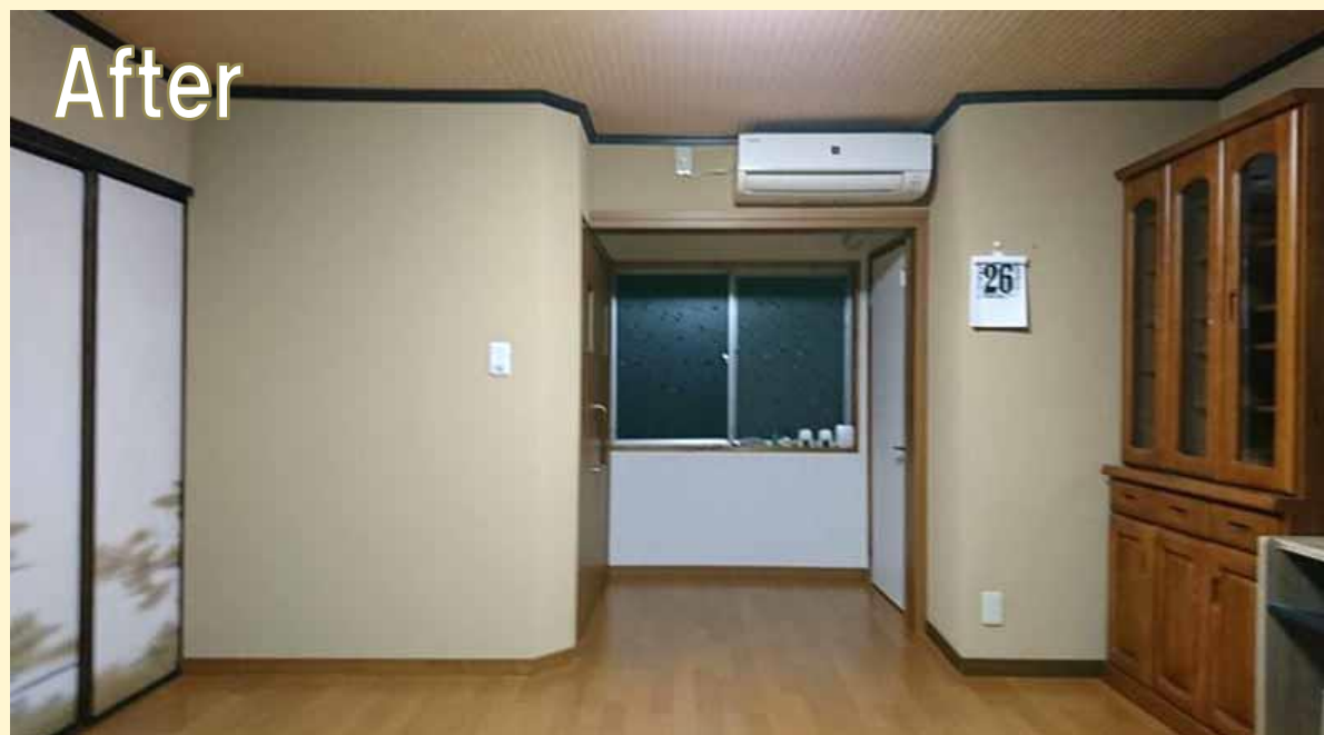
床が畳からフローリングになり、車椅子でも移動しやすくなりました！ おトイレとの間仕切り壁も違和感なく仕上がりました。
