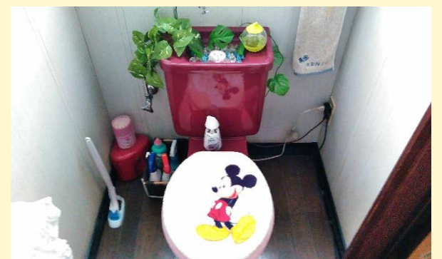
汲み取りから水洗トイレへのリフォームです。
