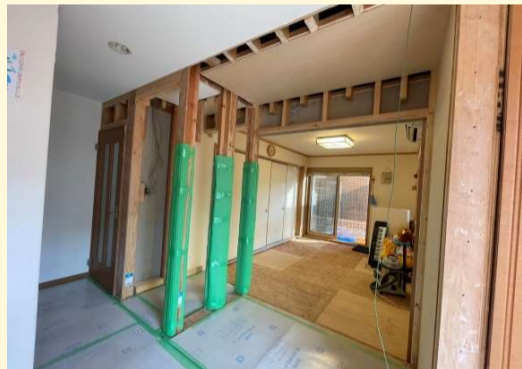
間取りを変える為に壁を撤去しました。
