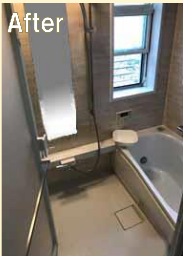
既存に合うオフロがなかったので、TOTOのマンションタイプを使用しました。
