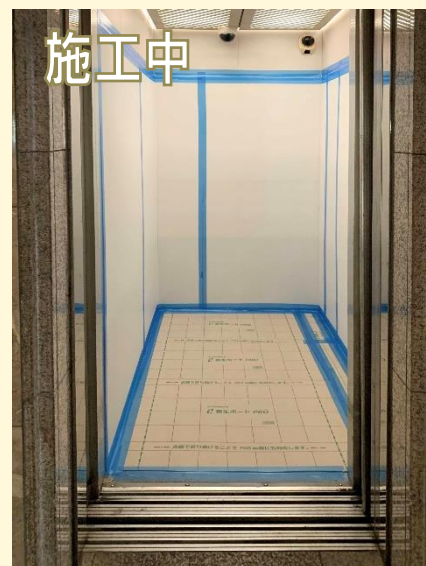
共有部分のエレベーターも養生
