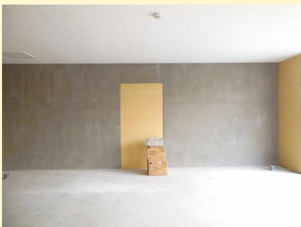
新築のテナントで何もない状態でした。
