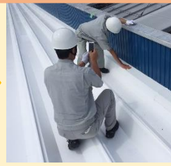
上塗り後完了検査
