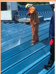
高圧洗浄施工
