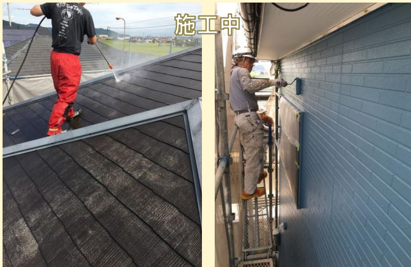
屋根の高圧洗浄中です。
