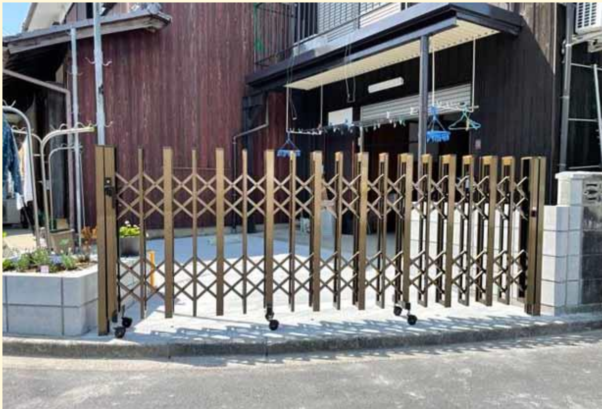
塀を解体し、サイドにブロックを積みフェンスを設けました。防犯対策もバッチリです！！
