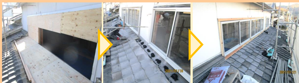
ベランダ野地施工
