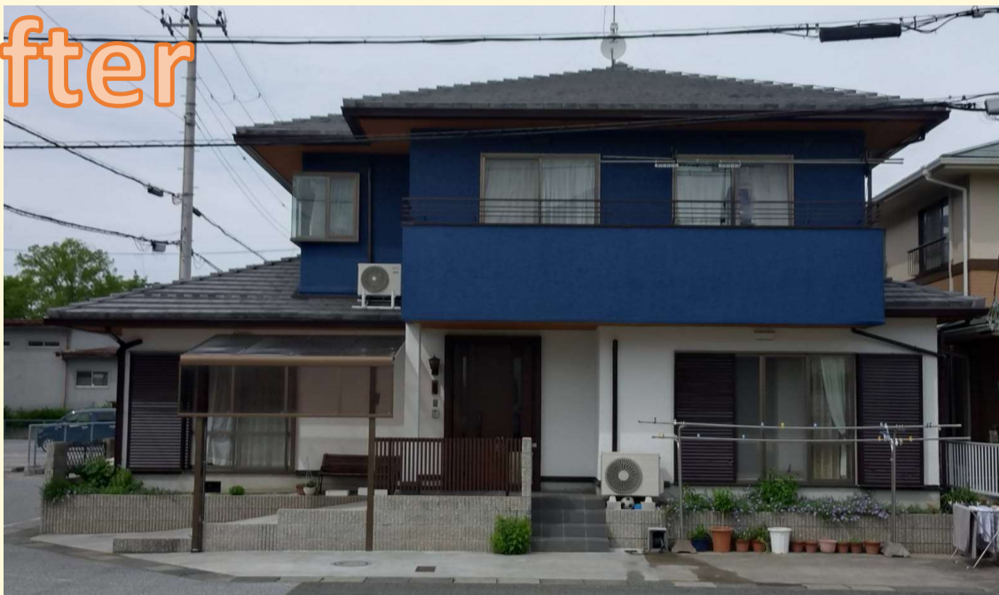
建物の上半分を濃い青に、下半分を白に塗分けました。
