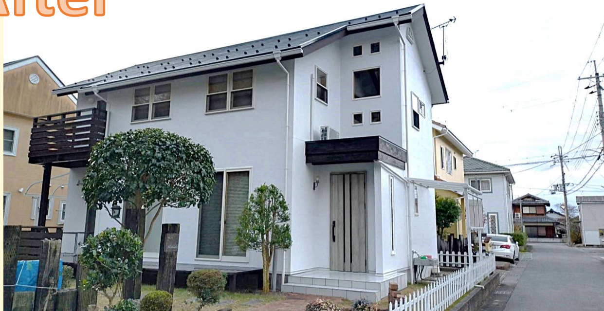
玄関の増築と外装の塗装がきれいに仕上がりました！
