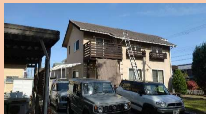
バルコニーや破風等の木部も塗装時期になっていました。
