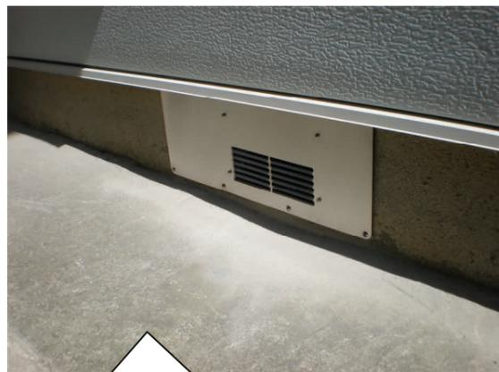
和室側面の基礎部分に強制換気システムを設置しました。既存のものと併用して、換気力UPです。
