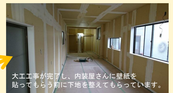
既存の床、壁、天井を解体し、大工さんに新しい下地を施工してもらっています。
