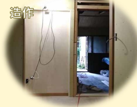
大工さんの手で新しい床、壁、天井を作っています。裏口への開口は最後にふさぐ予定です。
