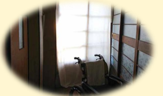
反対側の廊下の突き当りに窓がありますが、腰壁を無くし、裏のお庭に出やすくしたいとの事でした。
