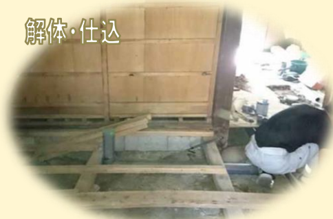
既存の床、壁、天井を解体撤去した状態に、配管と配線の仕込みをしています。
