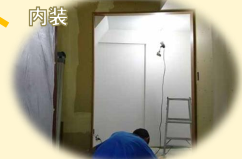
工事也大詰めを迎え、内装屋さん壁紙とクッションフロアを貼ってもらっています。
