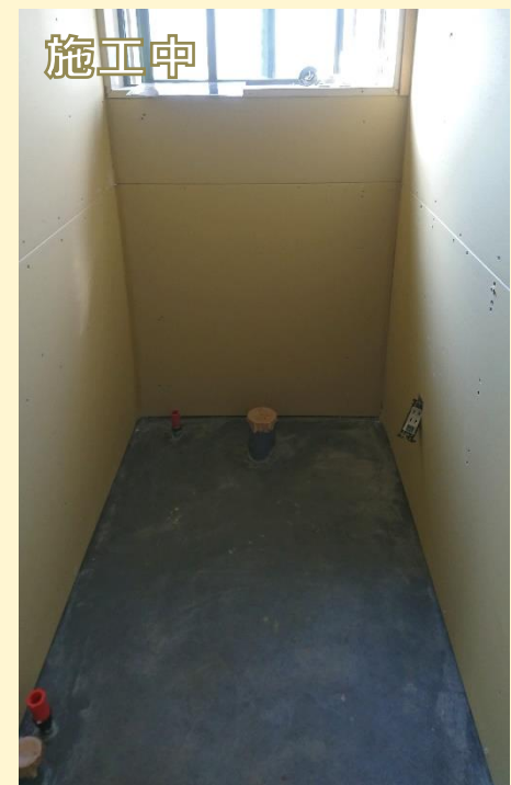
解体して既存のトイレの撤去です。
