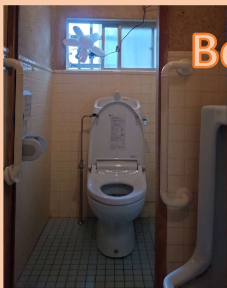
洋便器からの漏水がリフォームのきっかけでした。
